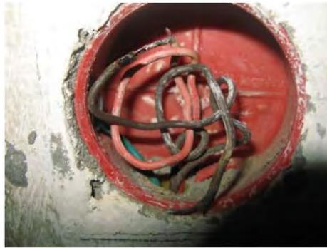
Prises et interrupteurs saillants. Les phases sont sous tension.
